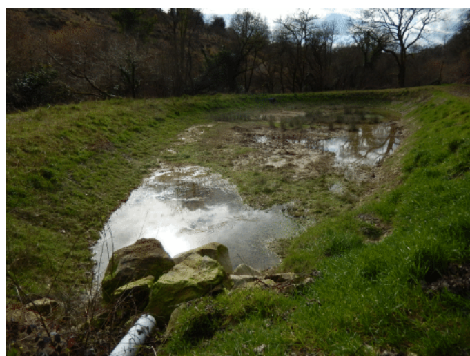
Dernier bassin de décantation avant rejet vers le milieu extérieur
