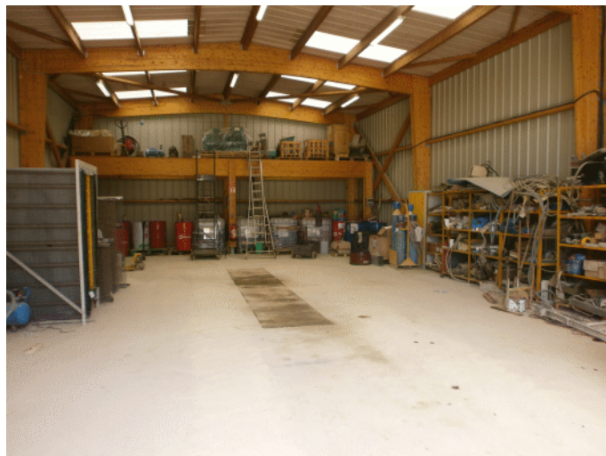
Caniveau dans l'atelier qui récupère les égouttures
