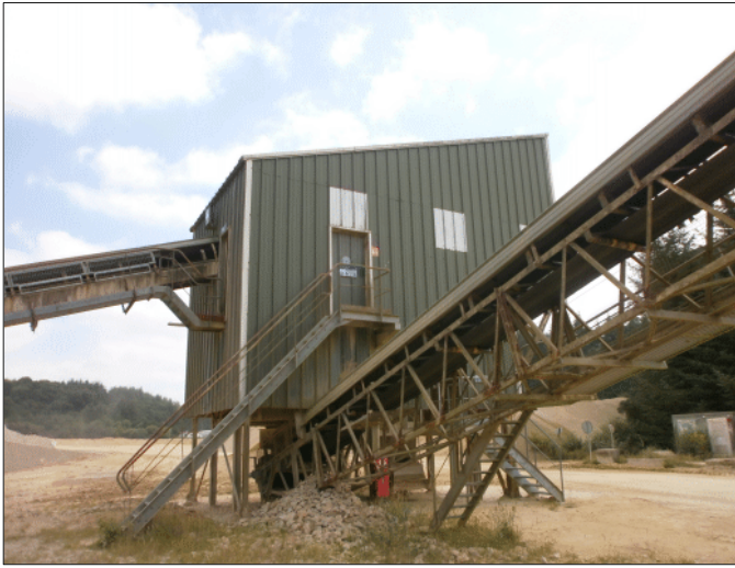
Bardage des installations
