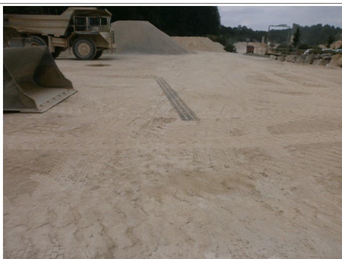
Zone de ravitaillement reliée à un déshuileur/débourbeur
