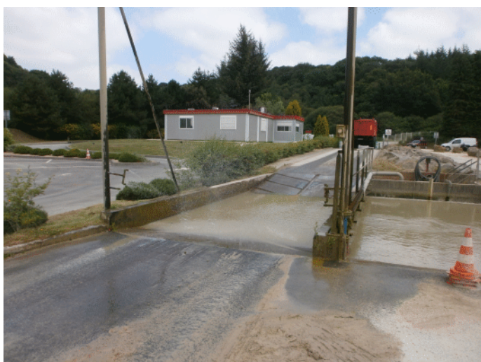
Laveur de roues + bassin de récupération des eaux
