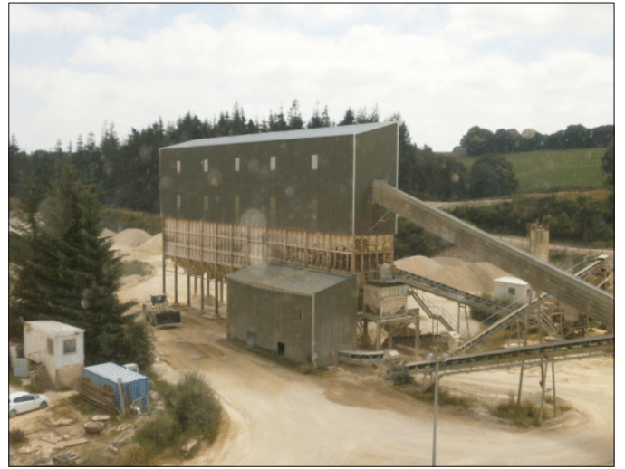
Bardage des installations
